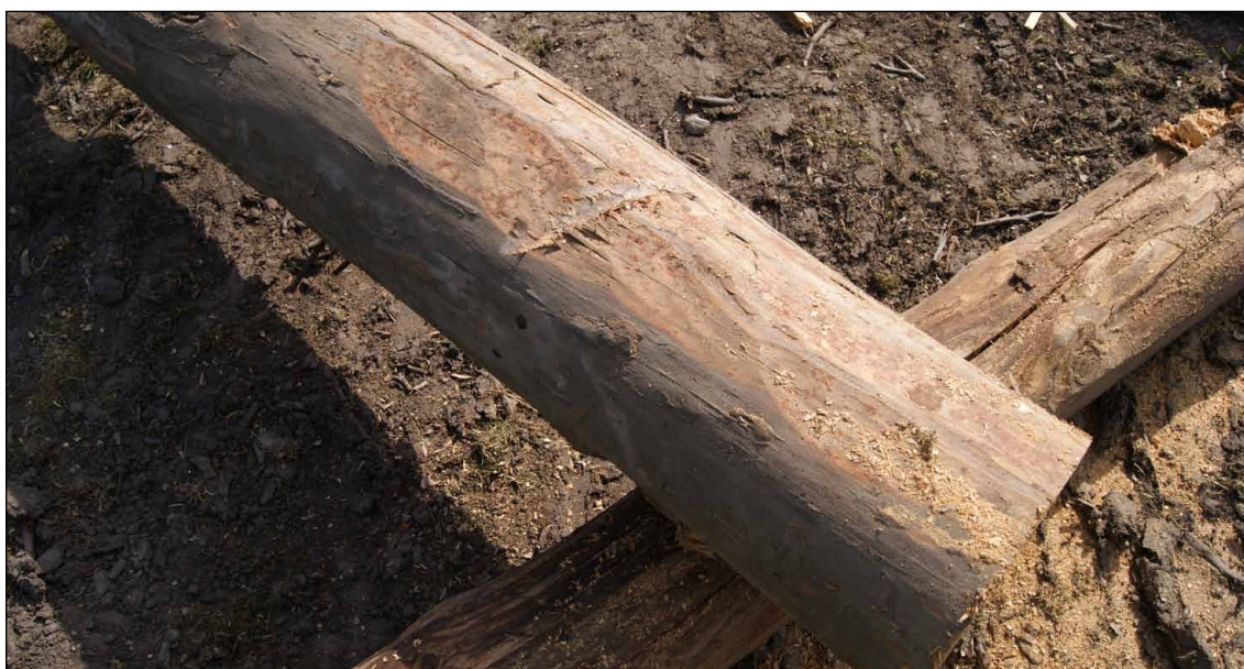
Afb. 18 Oppervlakkige bewerkingssporen op een van de elementen van het vierkant.
