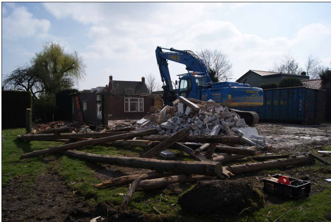
Afb. 15 De losse elementen van het vierkant tijdens de sloop.
