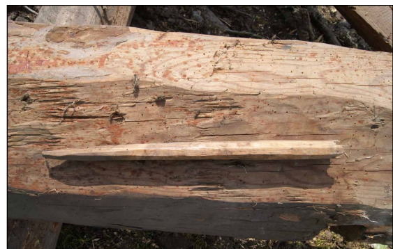
Afb. 23 Een lange toenagel van naaldhout, gebruikt voor het verbinden van de dekbalken en overstekbalken.
