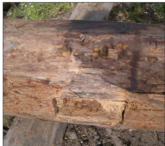
Afb. 21 Twee toenagels in de zijkant van een onderste dekbalk.
