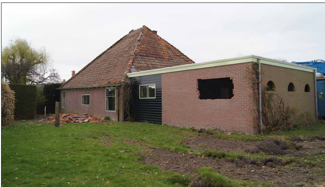
Afb. 14 De achterzijde van de kleine stolp bij de sloop in april 2012. De dakpannen zijn al grotendeels verwijderd.
