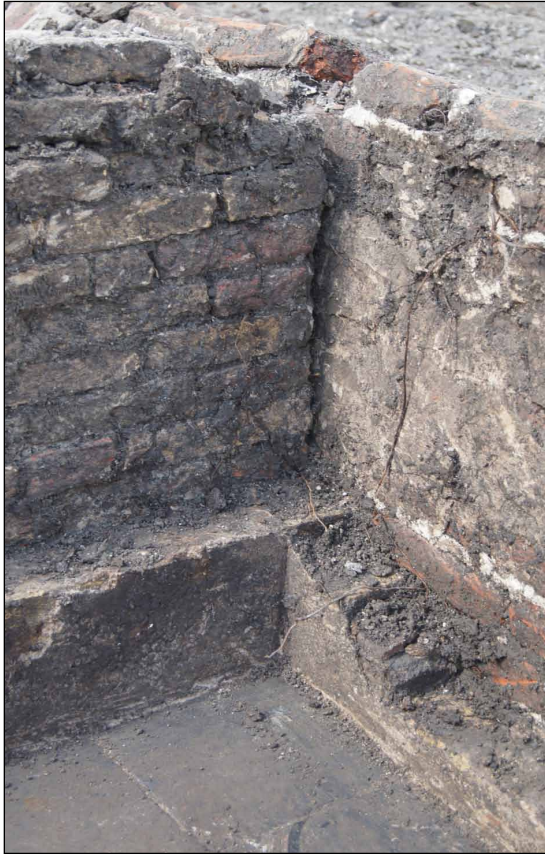
Afb. 49 Tussenmuur S46 (links) is koud tegen keldermuur S49 (rechts) aangezet.
