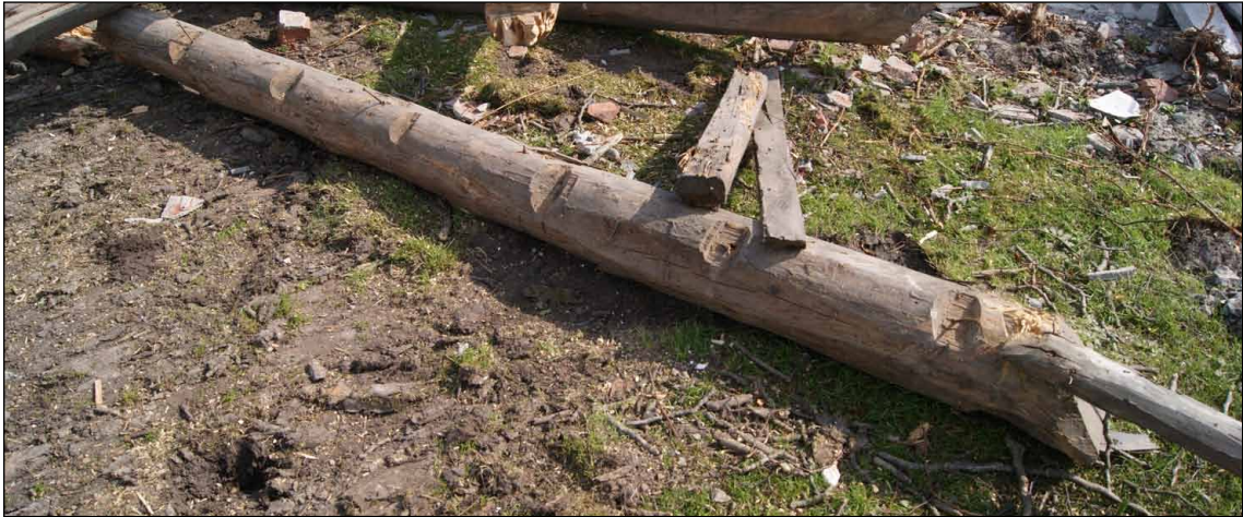
Afb. 19 Inkepingen voor de daksparren in een overstekbalk of dekbalk.
