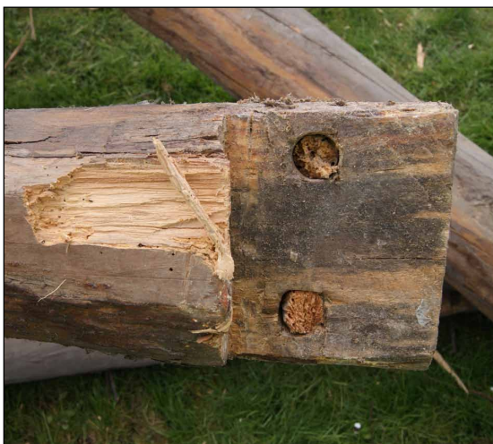
Afb. 20 Een rechthoekige pen aan de bovenzijde van een van de vierkantstijlen.
